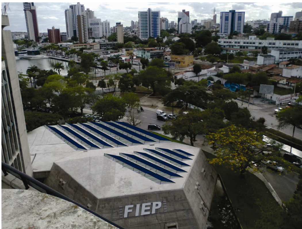
Figura 8.1. Montagem do prédio da FIEP mostrando os painéis dispostos na laje apontados para o norte.
