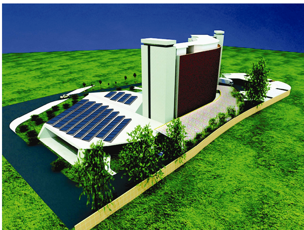
Figura 8.2. Montagem do prédio da Fiep mostrando a disposição dos painéis na laje.
