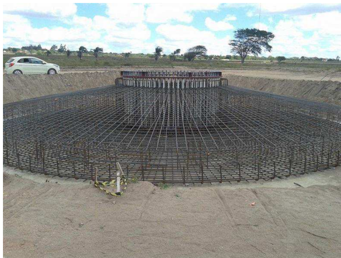
Figura 50. Preparação de fundação pra fixação da torre.
