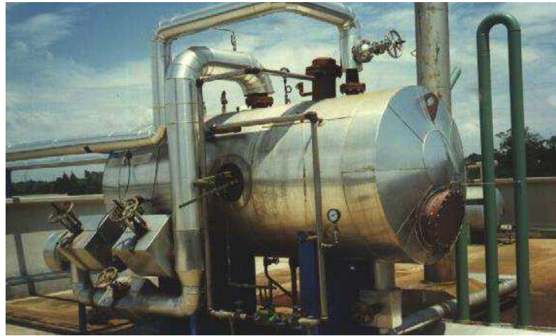
Figura 9: Desaerador. Fonte: Projeto da UTE.
