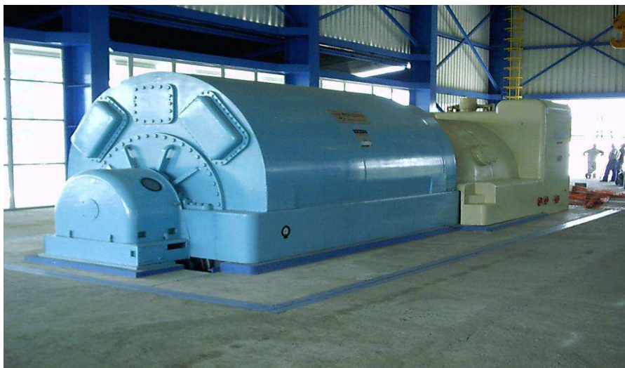
Figura 6: Conjunto turbogerador.
