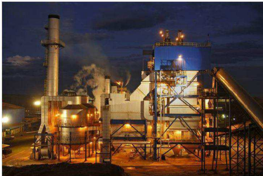
Figura 5: Vista geral de uma caldeira de biomassa. Fonte: Projeto da UTE.
