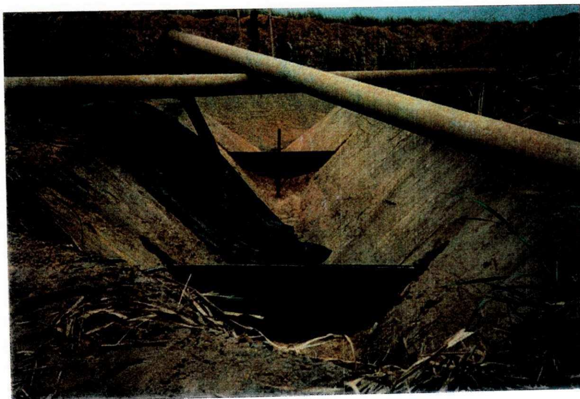
Figura 6 - Comportas utilizadas para conseguir o estancamento do fluido nos canais.
