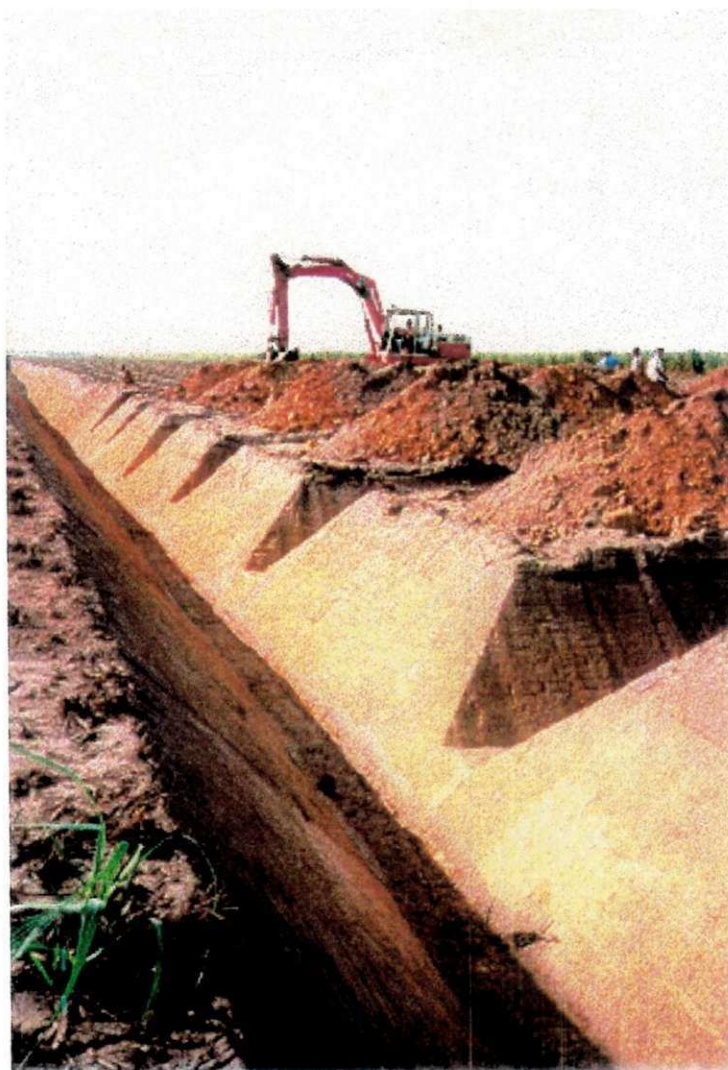
Figura 4 - Vista Parcial da Retroscavadeira abrindo os canais.
