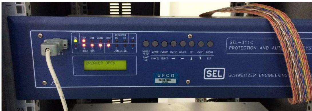
Figura 3.32: Atuação da proteção diante de uma falta fase b – fase c – terra (LED de *trip* aceso indica nível lógico um para este sinal; LED's B, de fase B, C, de fase C, e G, de *ground* – terra, em inglês – indicam a ocorrência deste tipo de falta)
