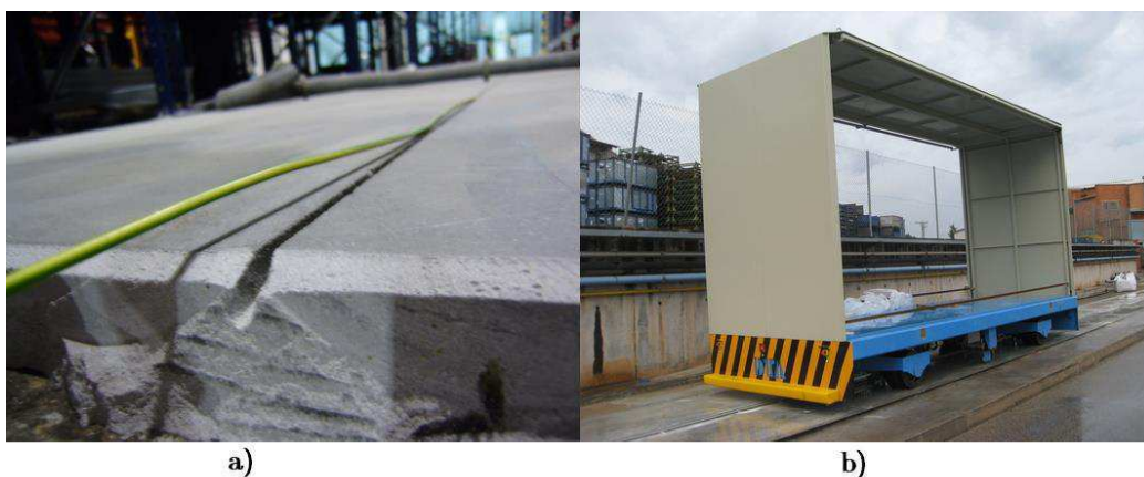
Figura 8. a) Detalhe da instalação do cabo condutor sob o piso; b) AVG filo guiado em operação. Fonte: [11].
