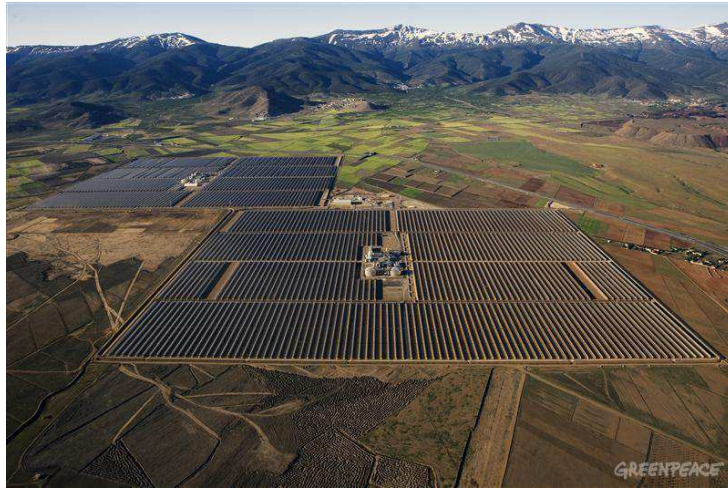
Figura 27 - Vista superior de uma das usinas Andasol, localizadas na Espanha.
