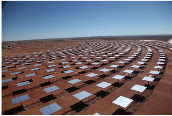
Figura 34 - Campo de heliostatos na usina Khi Solar One, na África do Sul.
