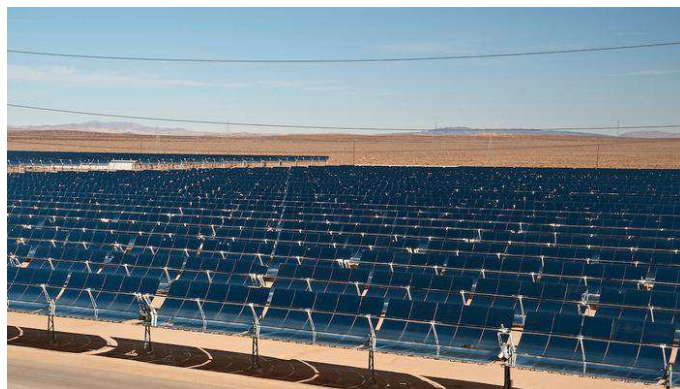
Figura 15 - Parte de um campo de coletores da SEGS, Deserto Mojave – EUA.
