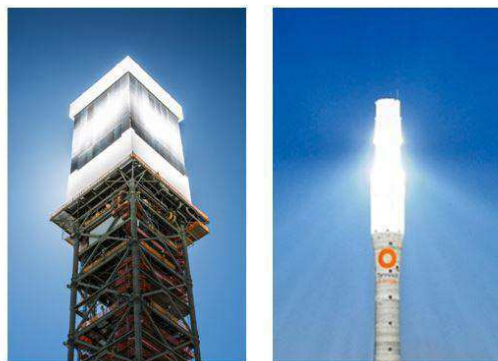
Figura 36 - Estrutura de suporte de aço (à esquerda), e de concreto (à direita).
