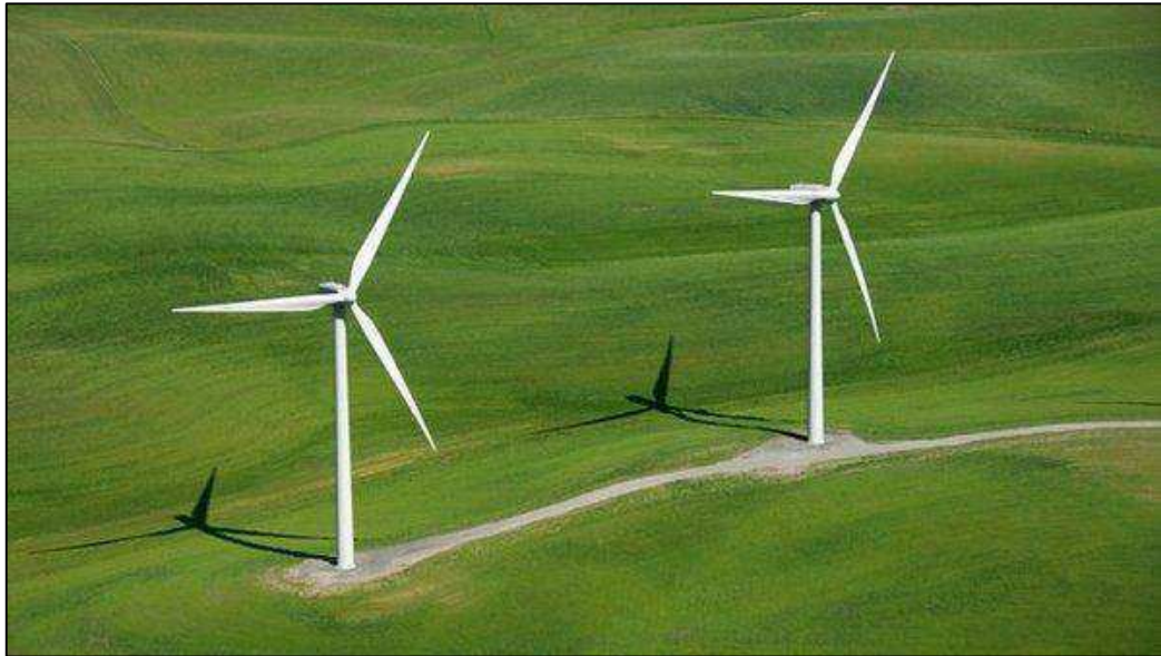
Figura 18 – Turbina eólica de eixo horizontal.
