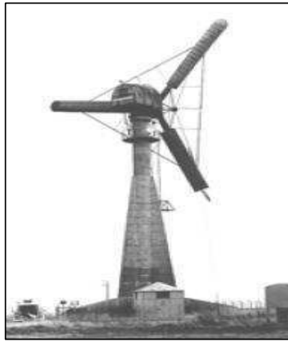
Figura 3 - Turbina Gedser
