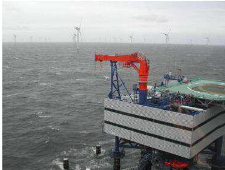
Figura 39 – Subestação offshore Horns Rev 1.
