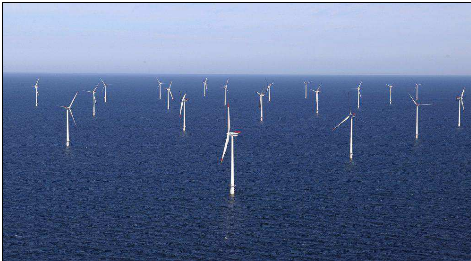
Figura 35 – Disposição dos aerogeradores do parque eólico Horns Rev 1.
