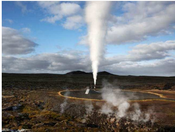
Figura 8: Imagem de uma válvula geotermal liberando o vapor resultante do processo de geração, no CPD da Verne Holdings .
