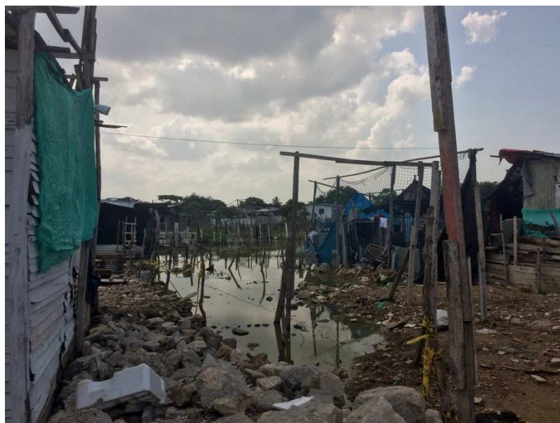
Figura 3: Esgoto a céu aberto em Isla de Leon , Cartagena.
