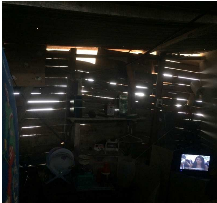
Figura 4: Habitação em Isla de Leon antes da instalação da Lâmpada de Moser.
