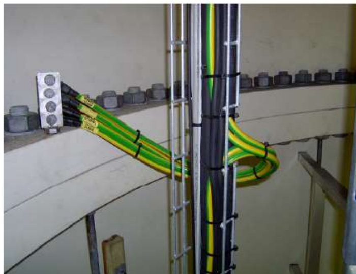
Figura 30 - Conexão dos cabos de descida
