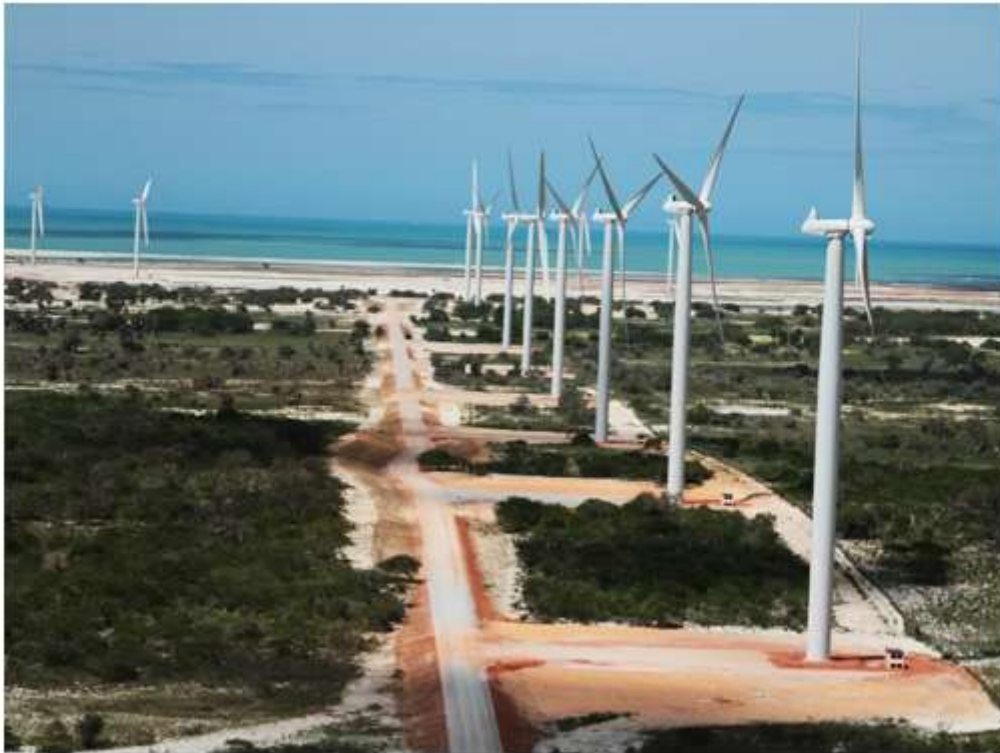
Figura 24 - Disposição dos aerogeradores
