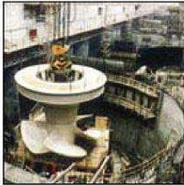
Figura 11 - Imagem de turbina Hélice.
