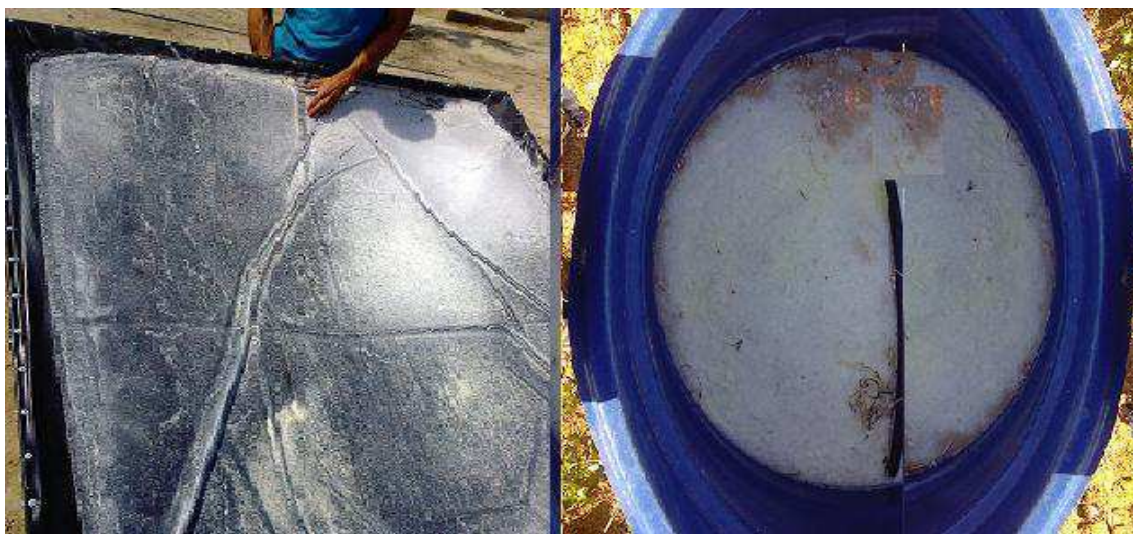
Figura 27: Limpeza dos sais acumulados sobre a lona encerado, e armazenamento dos sais em uma caixa de PVC (310 litros), sítio Olho D'água, Seridó-PB
