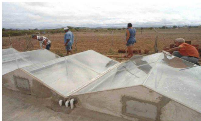
Figura 10: Dessalinizadores integrado ao P1+2, PA Corredor-Remígio-Pb.
