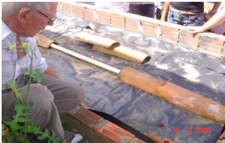
Figura 12: Estrutura em alvenaria dos canteiros econômicos do P1+2.
