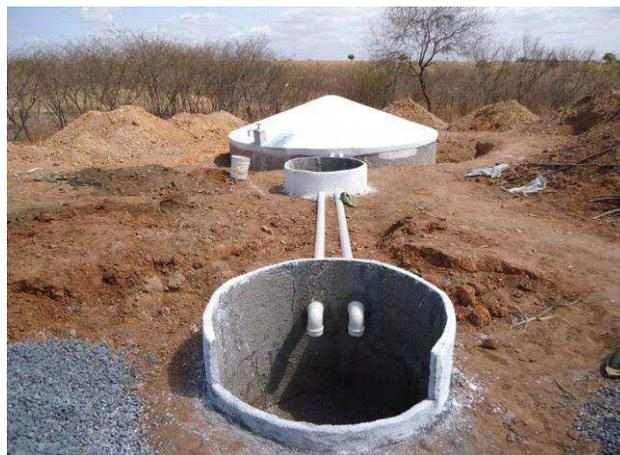
Figura 4: Cisterna de enxurrada, tanques de contenção com cisternas ao fundo.
