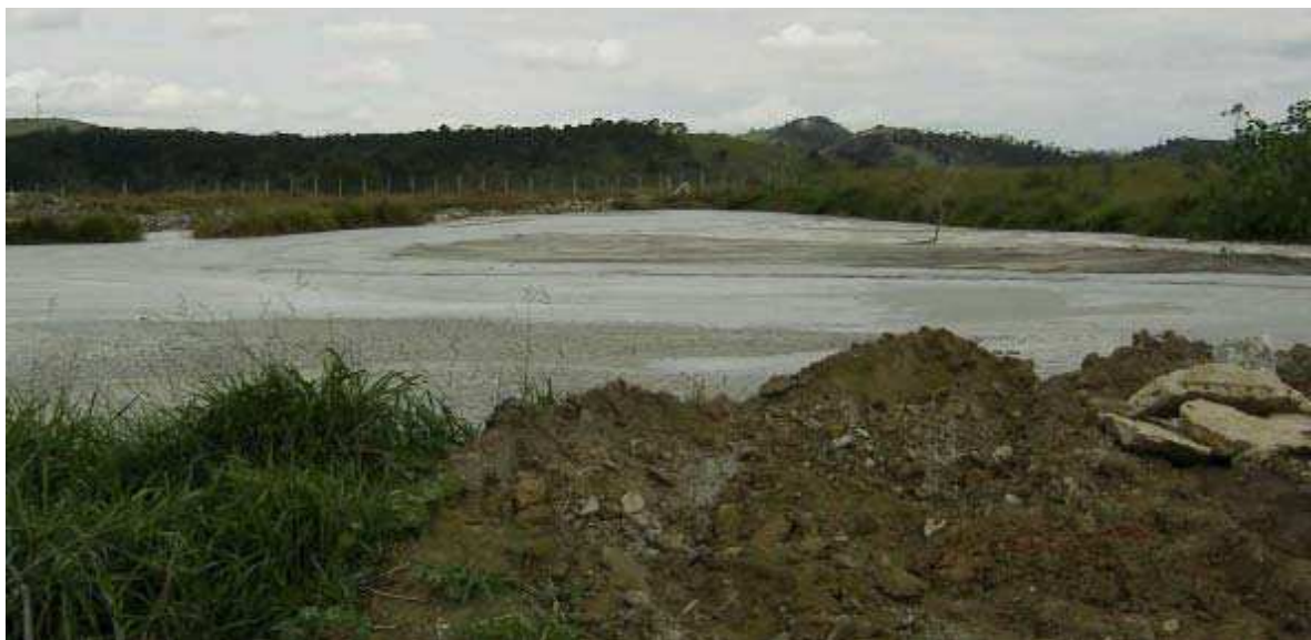
FIGURA 2.6: Lagoa de deposição de resíduo (lama). Fonte: BARRETO-NETO, 2007
