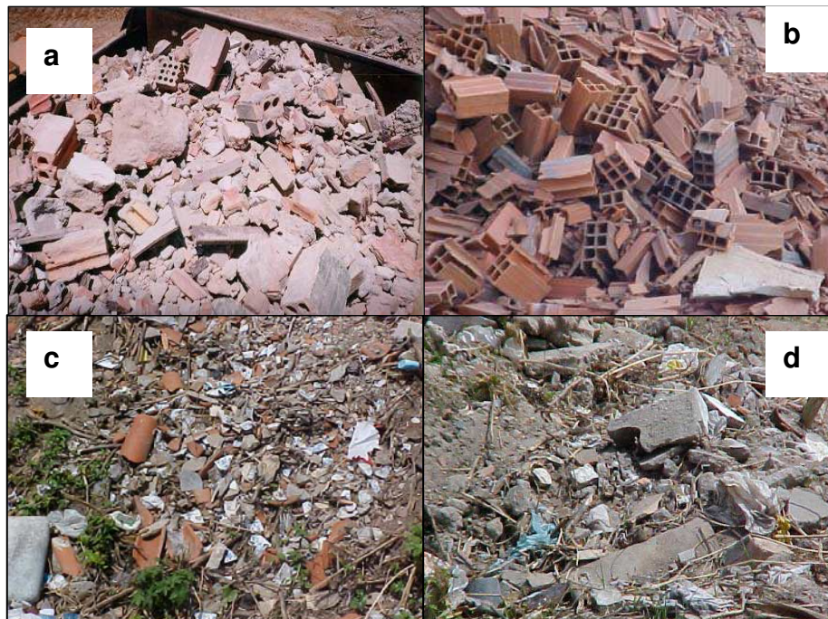
FIGURA 2.3: Resíduos de construção (a) e (b); resíduos de demolição (c) e (d)
