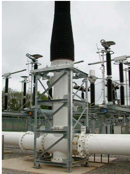
Figura 24: Transdutor capacitivo de tensão.
