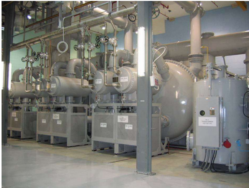
Figura 17: Transformador isolado a gás abrigado, haymarket, austrália.
