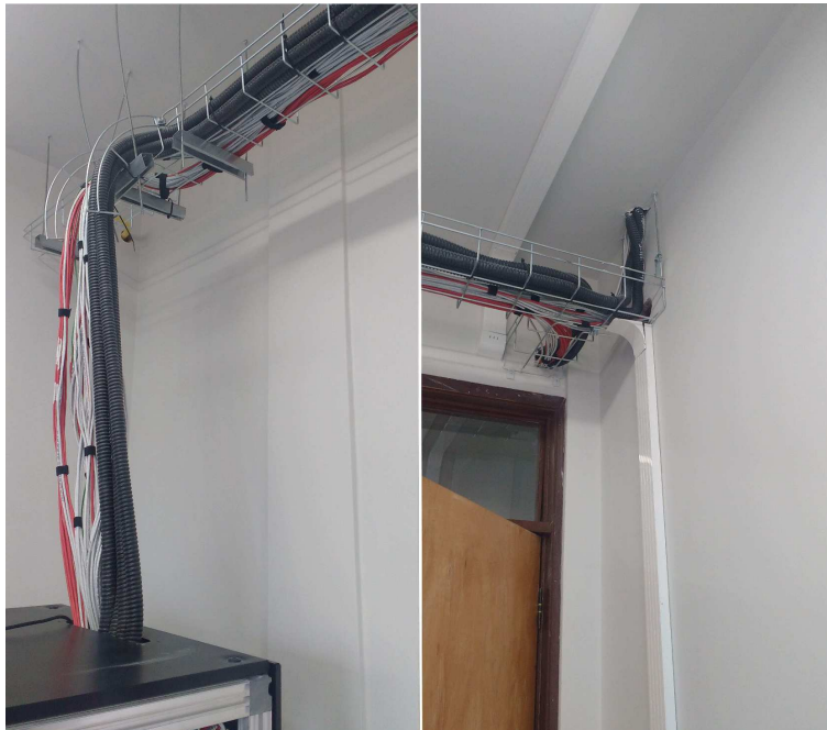
Figura 19 – Da esquerda para direita: Detalhe da descida dos cabos para o Rack-01A e interligação entre pavimentos
