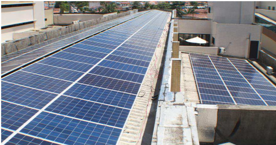
Figura 12: Fotografia minigeração fotovoltaica em um comércio.
