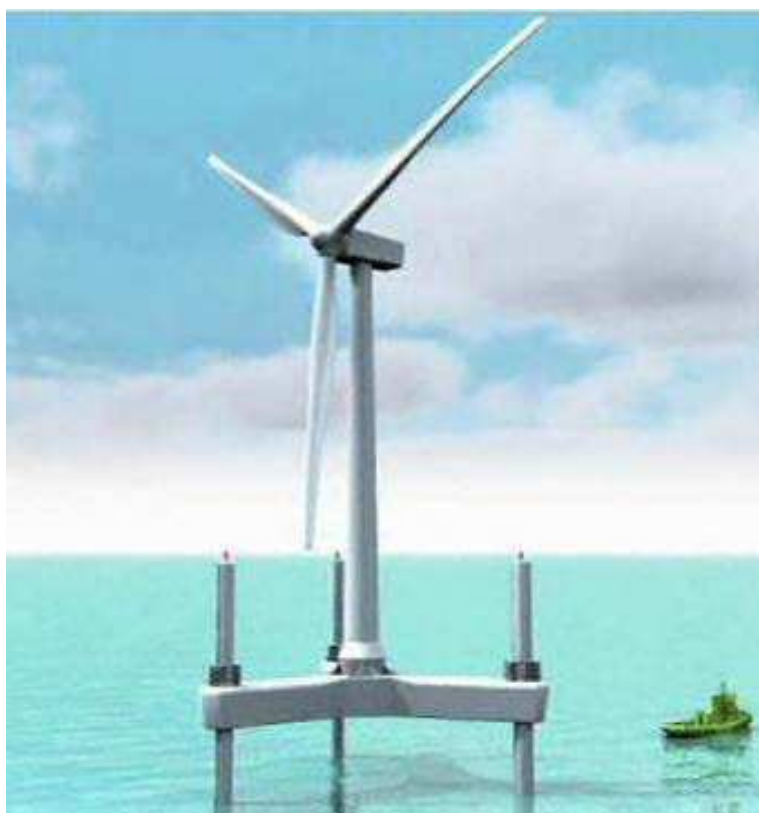
Figura 14 – Fundação tripod.
