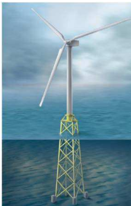
Figura 13 - Turbina eólica offshore com estrutura tipo jacket.
