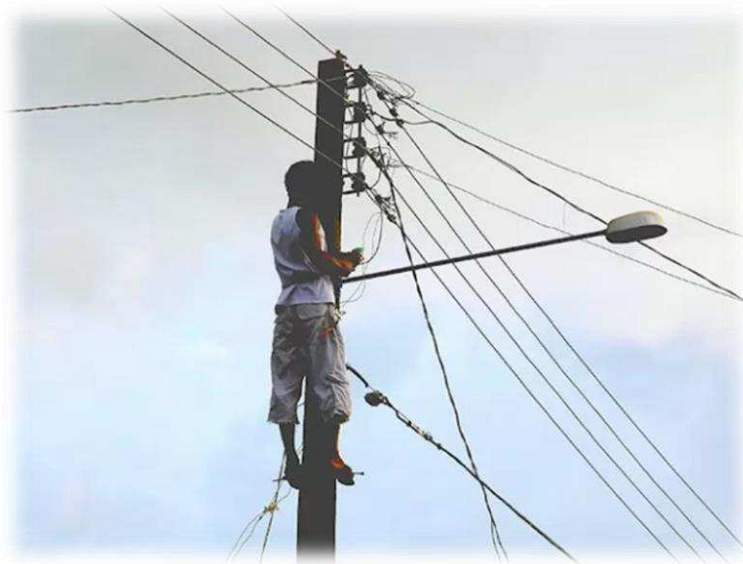
Figura 3. Flagrante da realização de ligação clandestina (“gato de energia”).
