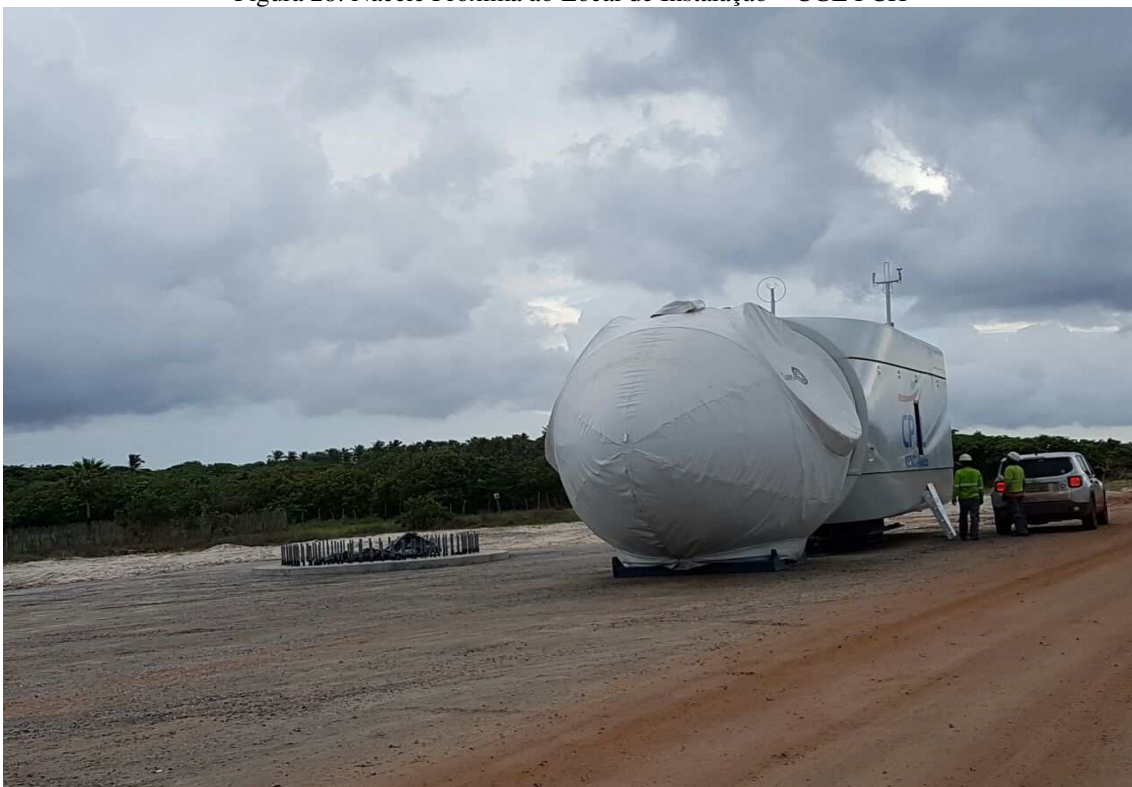
Figura 28: Nacelle Próxima ao Local de Instalação – CGE PCH
