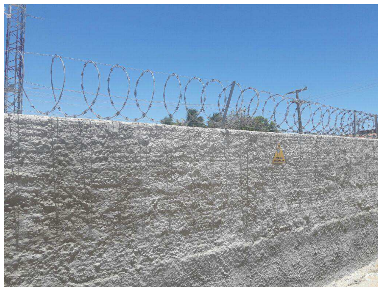
Figura 6 – Fotografia do muro externo da SE.
