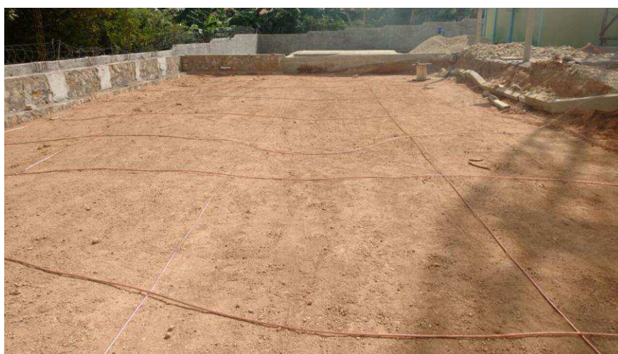
Figura 2 – Fotografia de uma área onde foi instalado a malha de terra, após o serviço de terraplanagem
