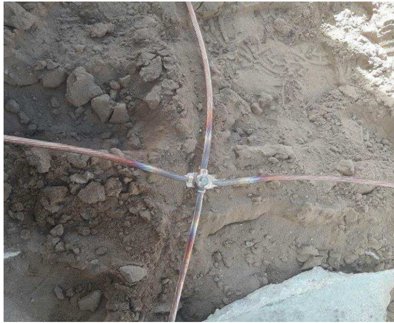
Figura 3 – Fotografia com detalhe de uma solda exotérmica
