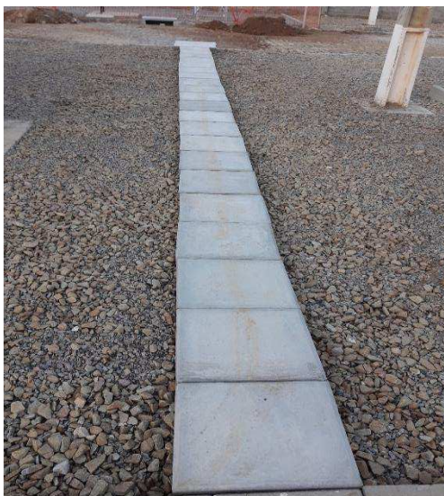
Figura 10 – Fotografia de uma canaleta fechada
