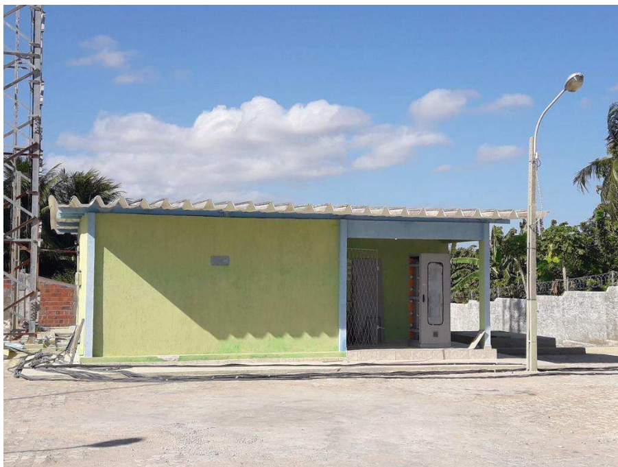
Figura 7 – Fotografia da Casa de Comando
