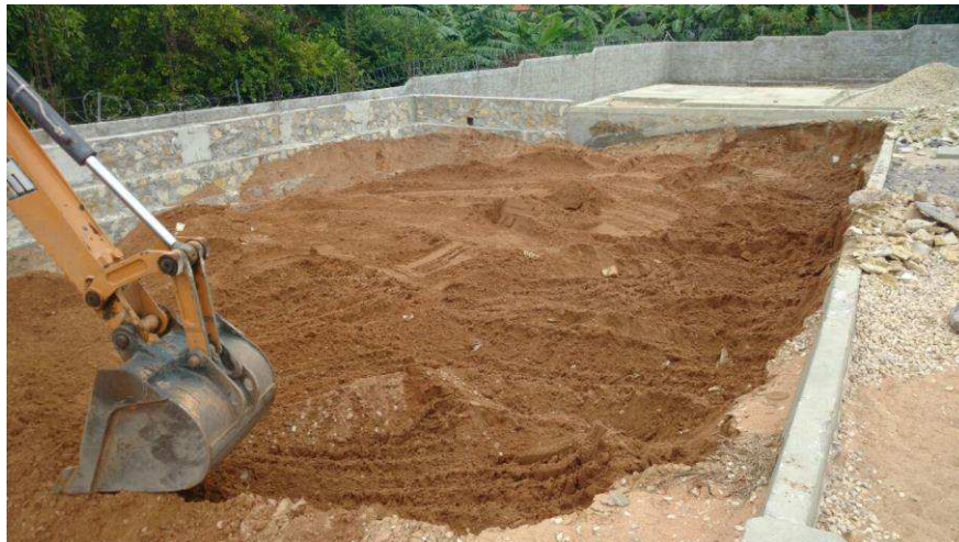
Figura 1 – Fotografia com trator executando o serviço de terraplanagem
