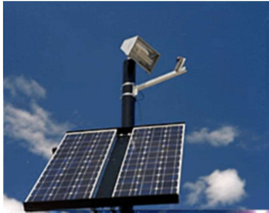
Figura 2.2 - Módulo de 100W para alimentação de um poste público utilizando baterias de 12 V.
