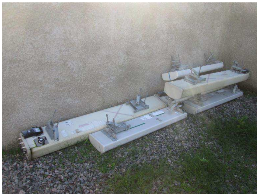
Figura 12: Antenas desinstaladas do site SLJGCR07
