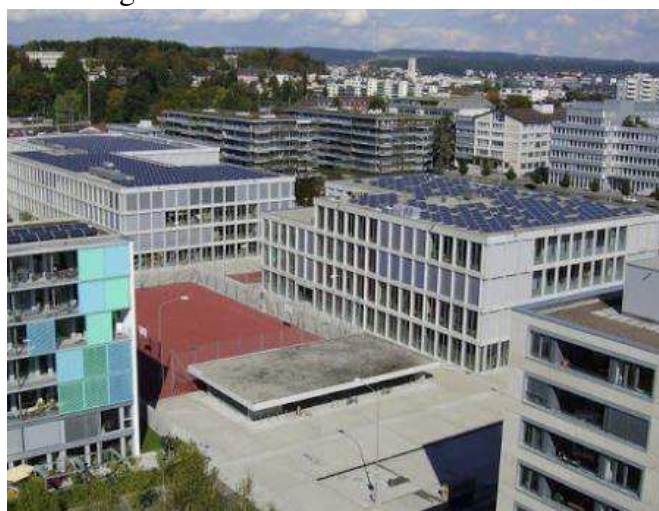
Figura 2: Prédio da escola " Im Birch ".
