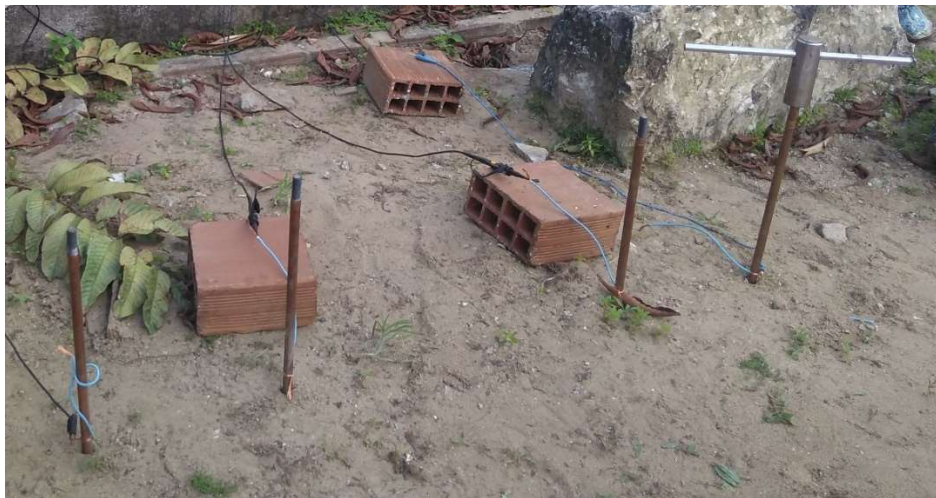
Figura 24: Fotografia da montagem para o ensaio diretamente no solo.
