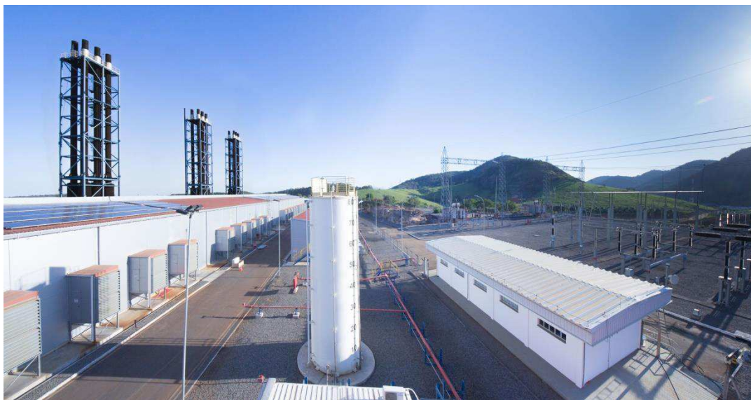
Figura 7 - Visão Geral de uma Usina Termoeletrica.
