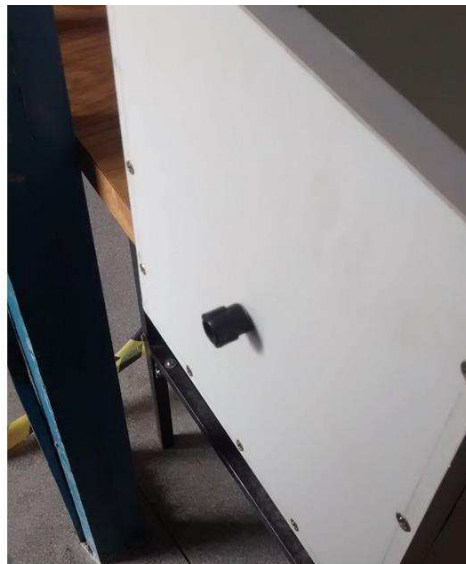
Figura 10: Instalação de um borne
