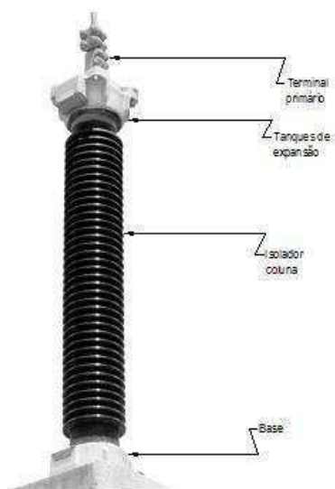
FIGURA 3: TP DA CLASSE 230 KV
