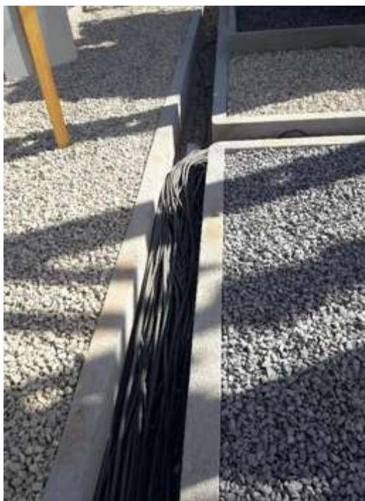
Figura 18: Cabos lançados na canaleta
