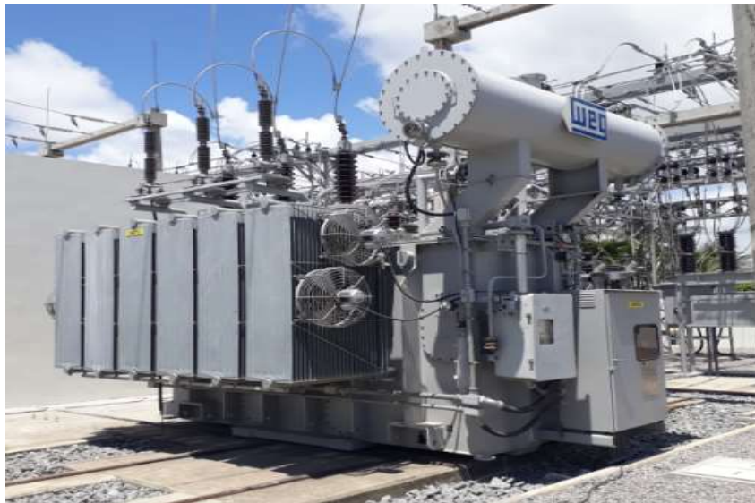
Figura 1: Fotografia de um Transformador de Força
