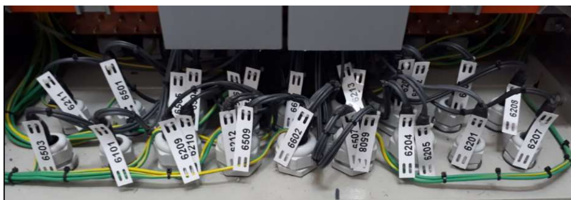
Figura 19: Cabos com seus respectivos TAGS
