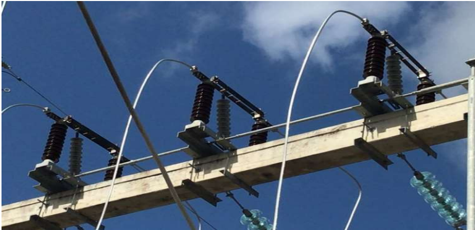
Figura 6: Fotografia de uma Chave Seccionadora
