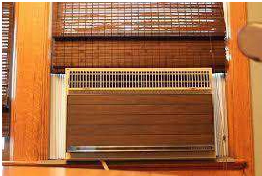
Figura 3: Aparelho de ar condicionado tipo janela
