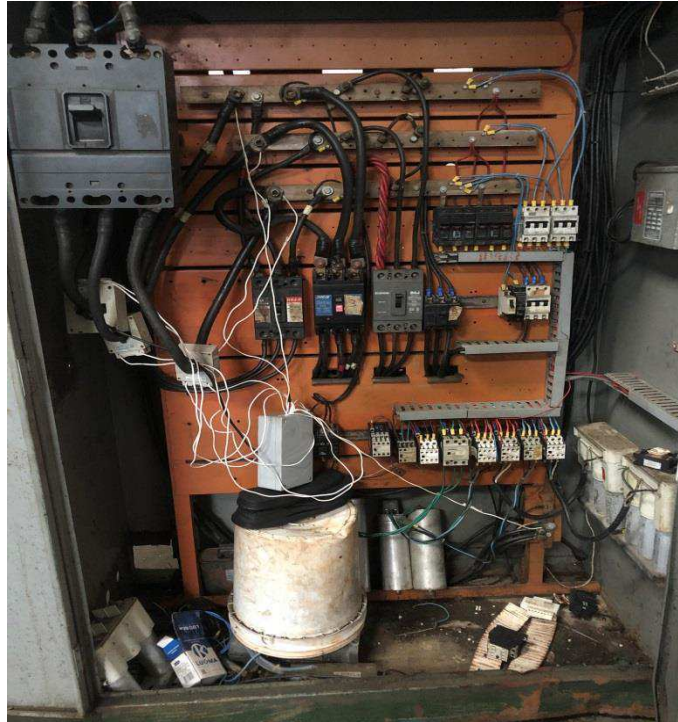
Figura 12: Medidor e ponto de instalação
