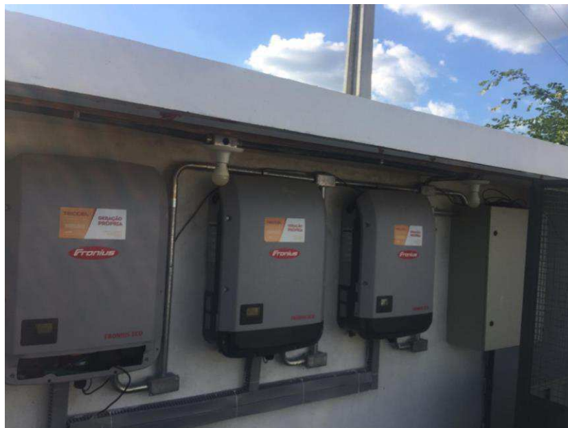
Figura 23 – Inversores fronius da UFV
