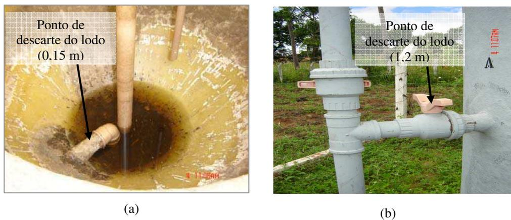
Figura 22 – Pontos de descarte do lodo de excesso do reator: (a) a 0,15 m da base e (b) a 1,2 m da base.
