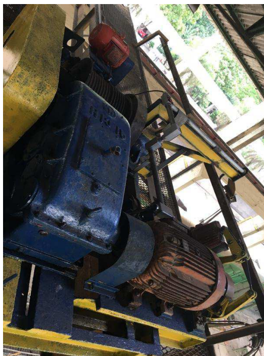
Figura 27 - Sistema de içamento de carga da talha elétrica.
