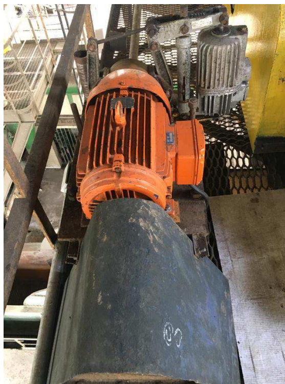
Figura 26 - Sistema de movimentação longitudinal de ponte rolante.
