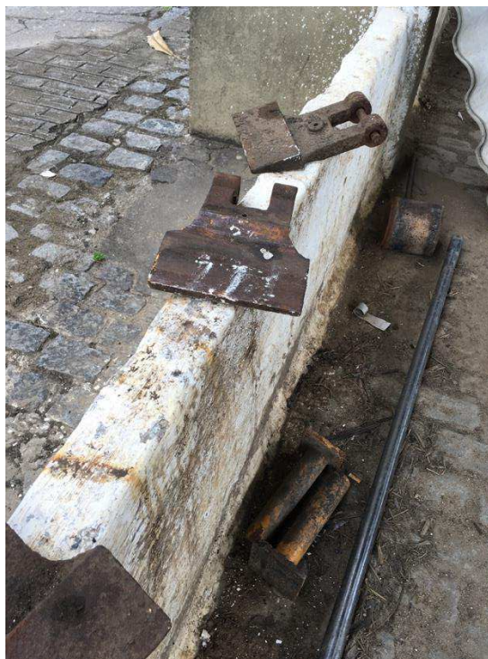
Figura 29 - Sapatas substituídas da ponte rolante.
