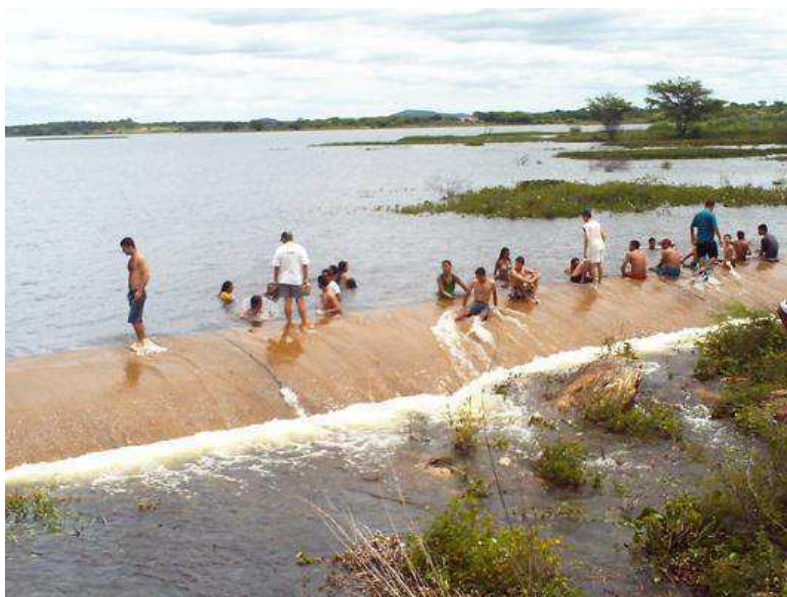
Figura 19: Tomada d'água do açude Sumé Fonte: Prefeitura Municipal de Sumé, 2009.
