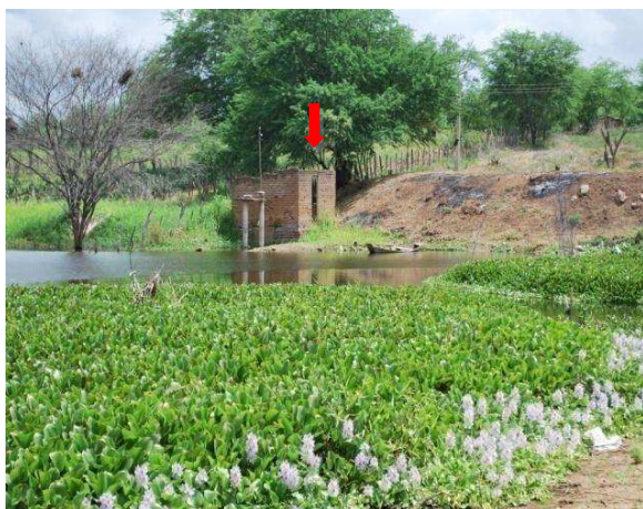
Figura 10: Edificação no entorno do reservatório. Fonte: Barreto, 2010.
