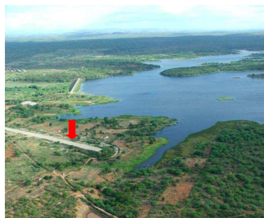
Figura 7: Edificações na APP. Fonte: Vidal, 2010.
