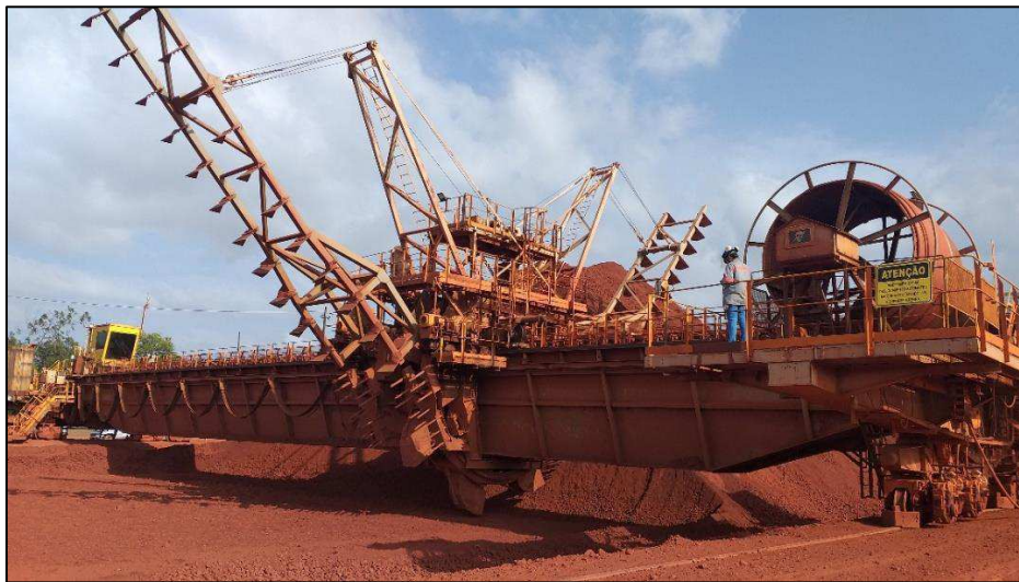
FIGURA 34 - RECUPERADORA ( RECLAIMER ) DE BAUXITA
