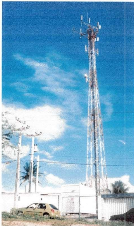
Figura 6 – Torre instalada na Avenida José Martins de Andrade, Santa Rosa.
