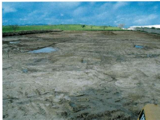
Figura 7: Terreno após a retirada de material orgânico.
