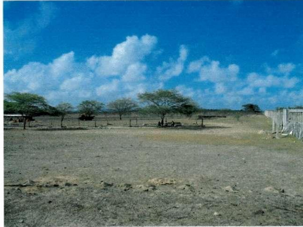
Figura 6: Terreno limpo para início das escavações.
