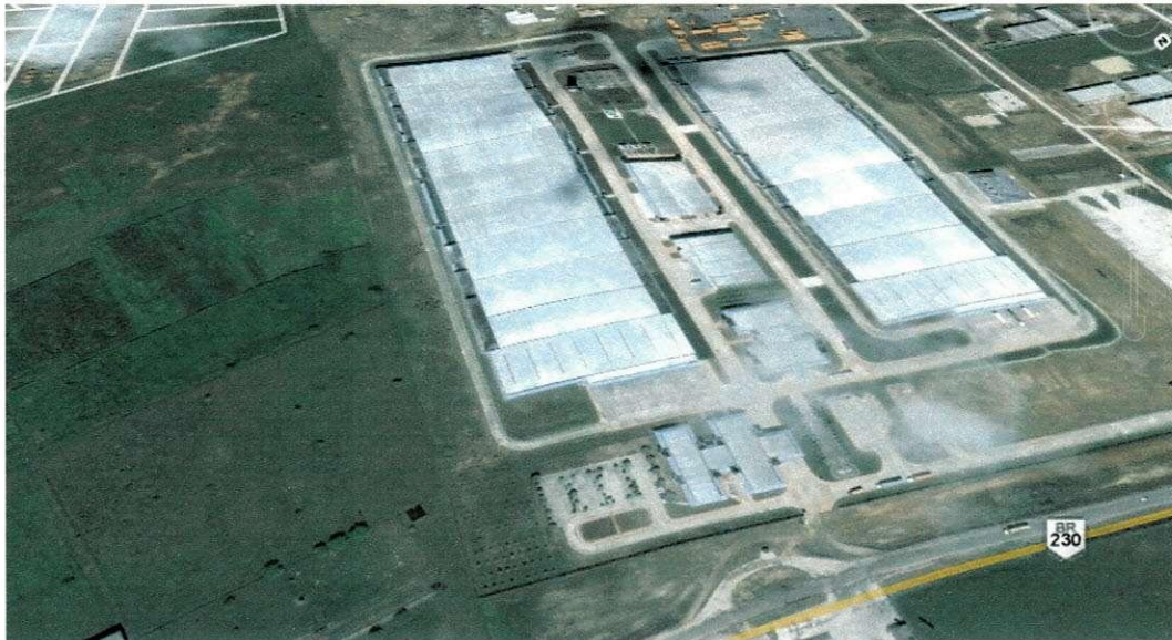
Figura 1: Vista aérea da Coteminas-CG. À esquerda a EMBRATEX e à direita a WENTEX (Retirado do software Google Earth em 03/09/08).
