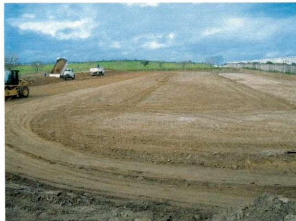
Figura 8: Etapa de depósito e compactação de material
