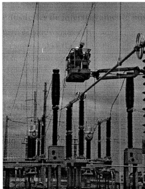
Figura 3.10 – Comissionamento da Subestação 230 kV.
