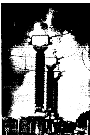
Figura 2.15 – Transformadores de Corrente – SE Muricy I
