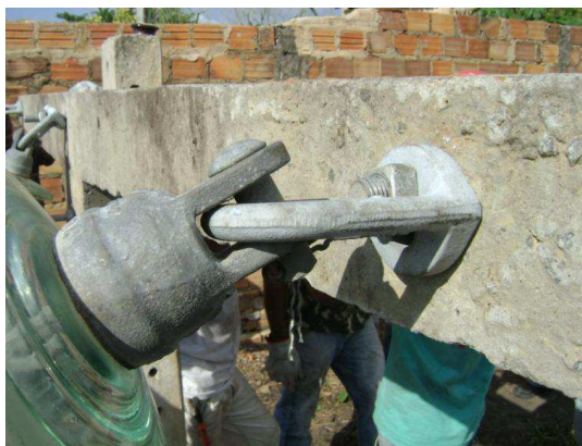
Figura 18: Instalação de Isolador Tipo Suspensão.
