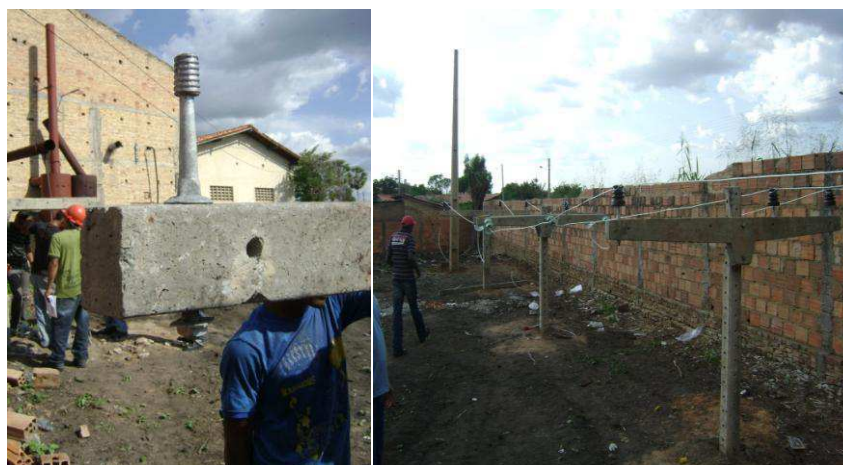
Figura 20: Pino de Topo para montagem do isolador de pino – Linha de Distribuição Didática.
