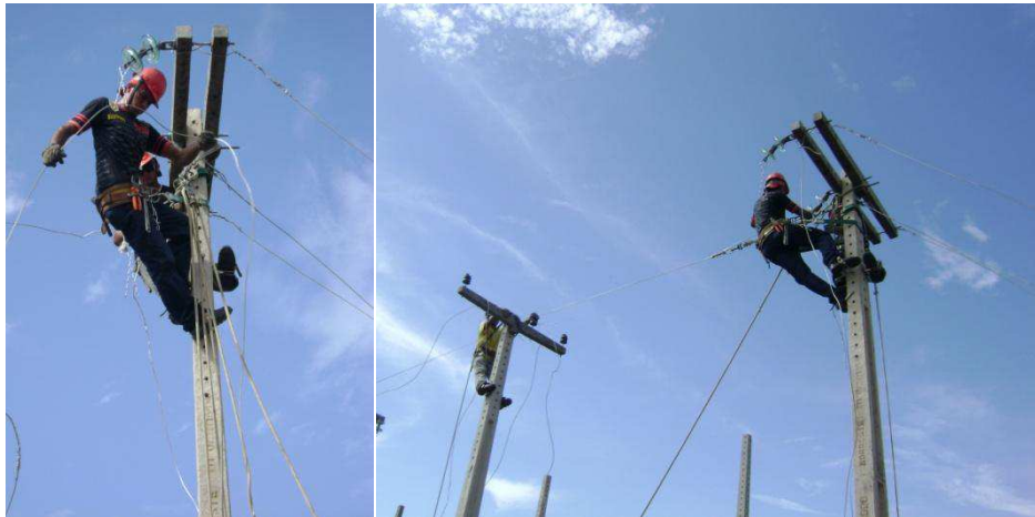
Figura 22: Puxada do cabo utilizando o Moitão.
