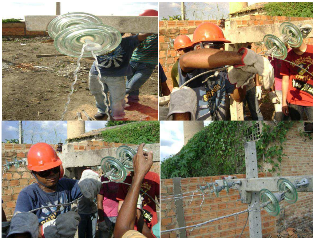
Figura 19: Fixação do cabo elétrico à estrutura.
