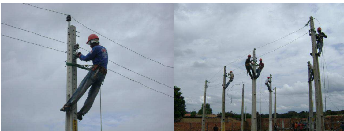
Figura 21: Montagem de RD Primária e Secundária (AT-BT)
