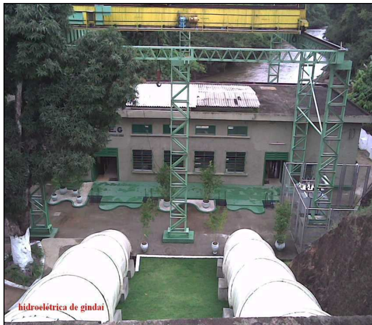
Figura 6.4.1 – PCH Gindaí da Usina Trapiche
