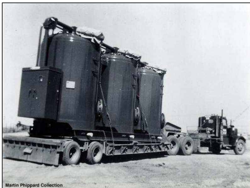
Figura 10: Disjuntor à Grande Volume de Óleo.
