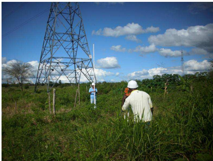
Figura 1 - Fotografia do Topógrafo Realizando Levantamento Topográfico
