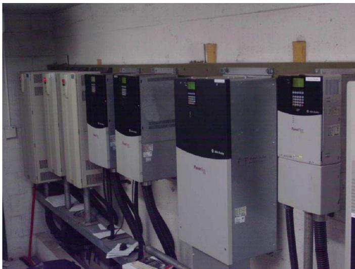
Figura 12 – Inversores de frequência do CCM 5
