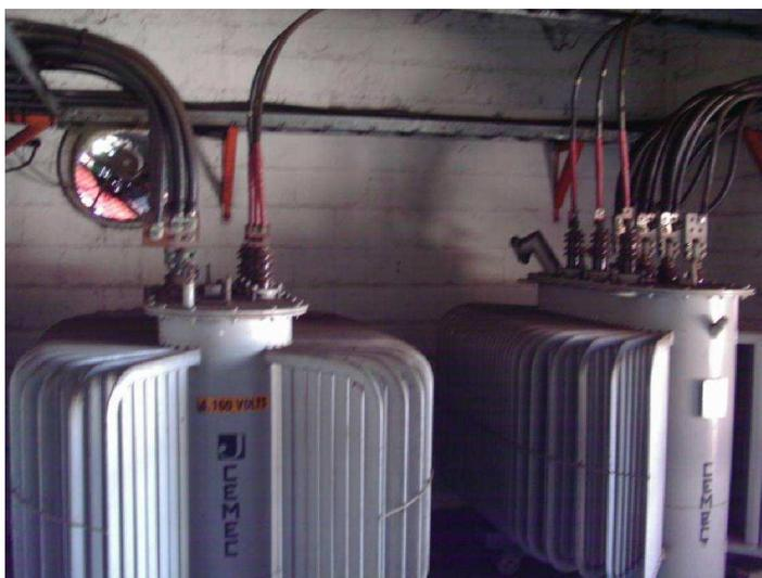
Figura 14 – Transformadores em paralelo de 1.000 kVA cada
