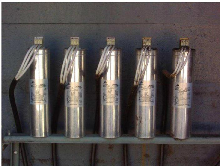
Figura 16 – Capacitores para correção do fator de potência no CCM 5
