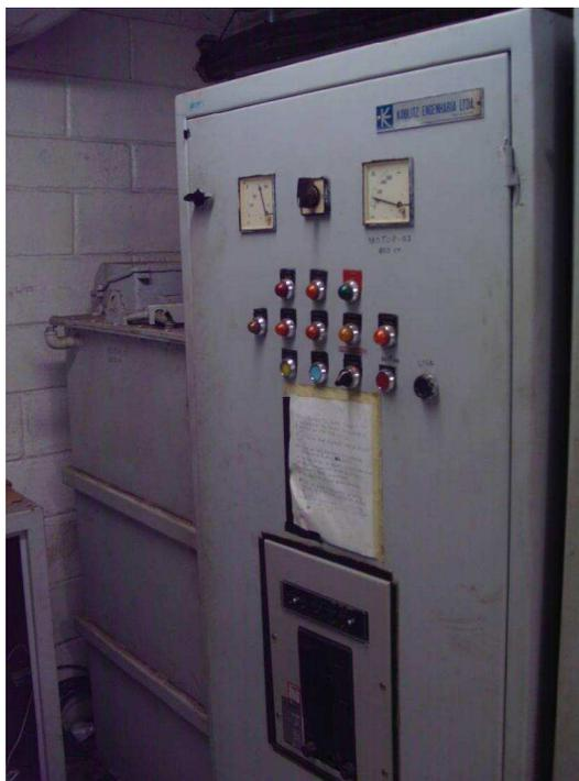
Figura 11 – Pannel de partida de motor a rotor bobinado com reostato
