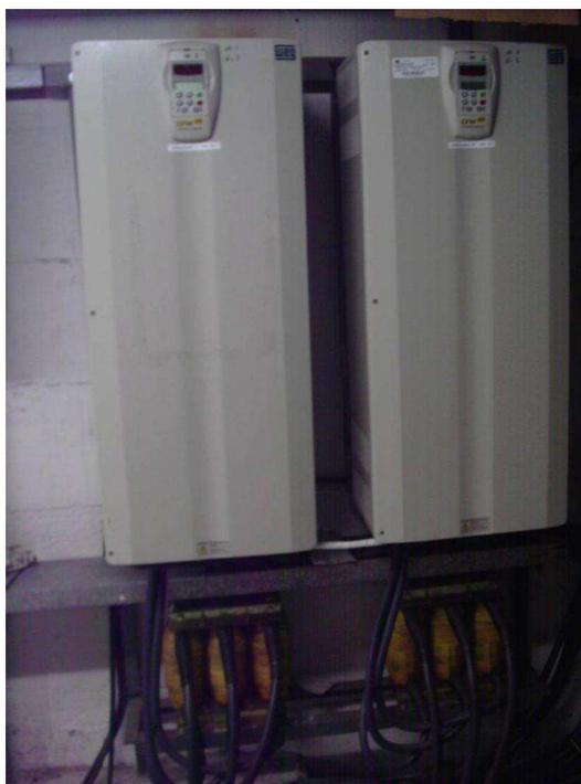
Figura 13 – Inversores de frequência com filtros de harmônicos
