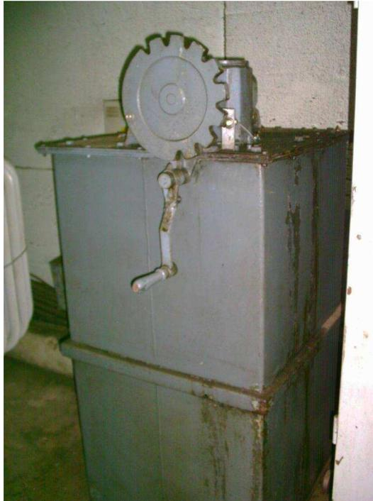
Figura 17 – Reostato a manivela para partida de motor de rotor bobinado de 800 cv
