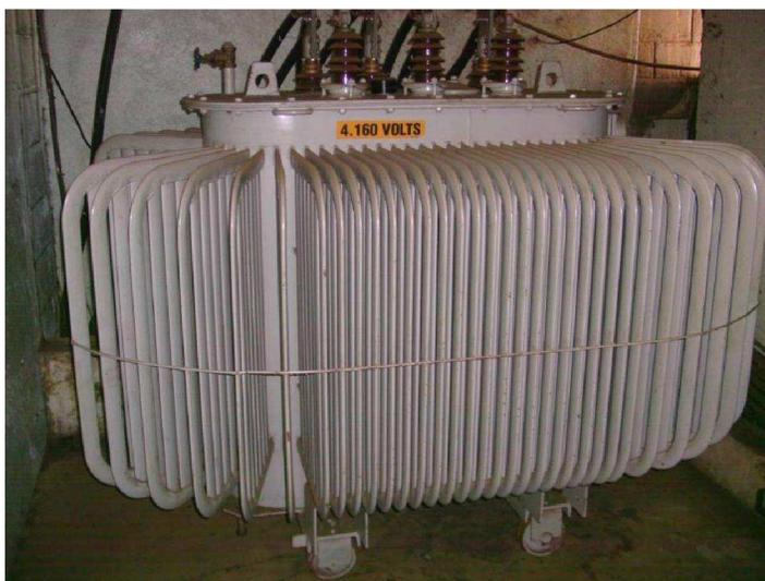
Figura 15 – Transformador do Barramento 2 de 1.000 kVA
