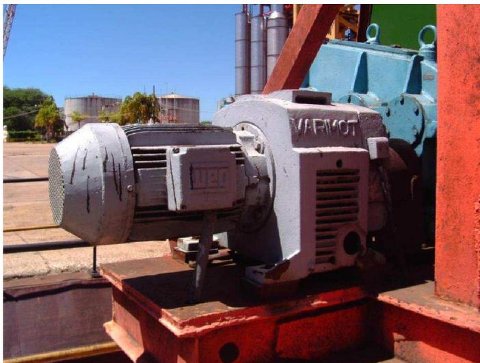
Figura 7 – Motor a indução acoplado a variador eletromagnético
