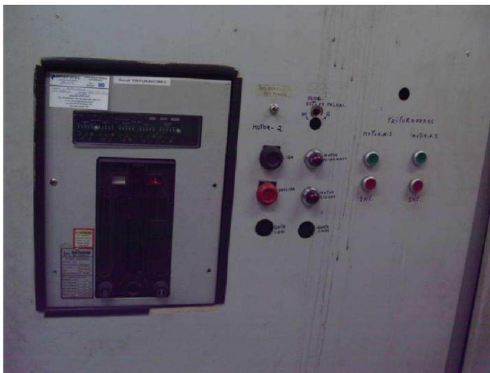
Figura 10 – Disjuntor de caixa aberta de 1.250A
