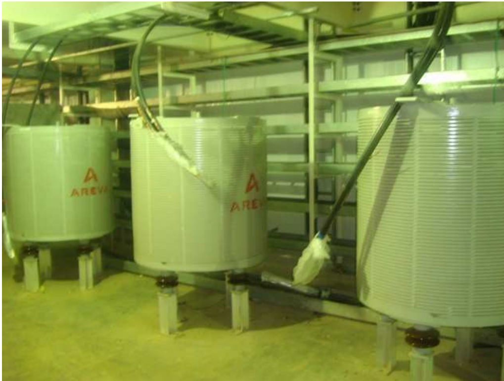
Figura 8: Reator limitador de corrente de curto-circuito
