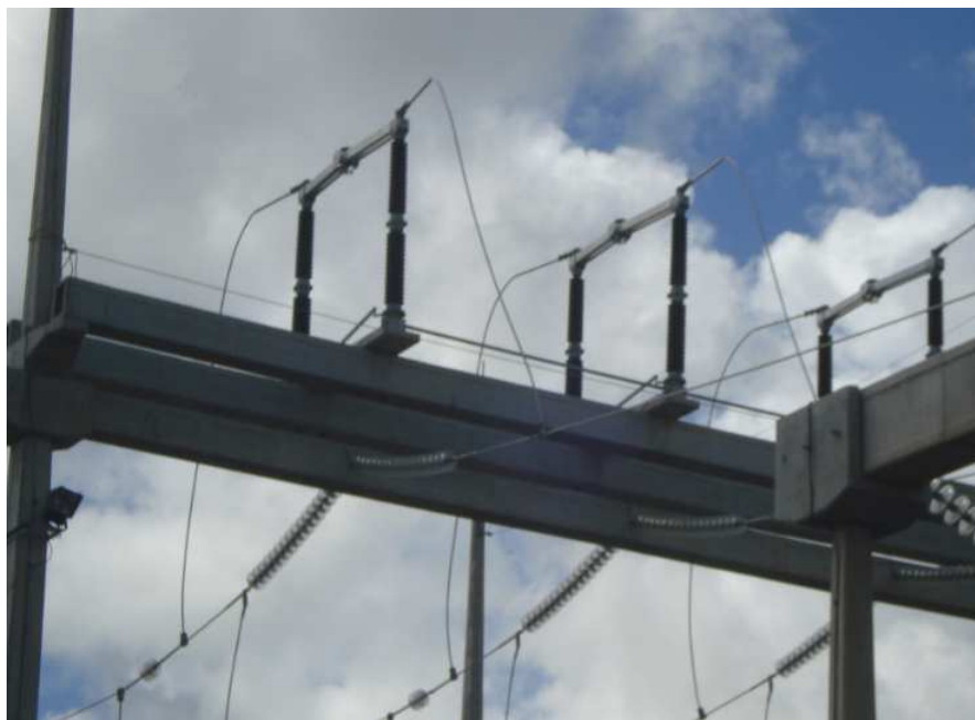
Figura 31: Seccionadoras com alongador
