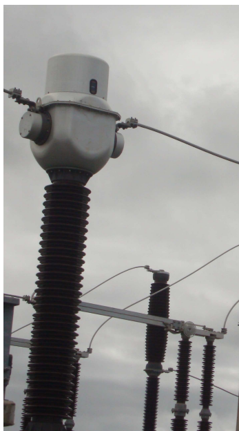
Figura 25: Transformador de Potencial Artech
