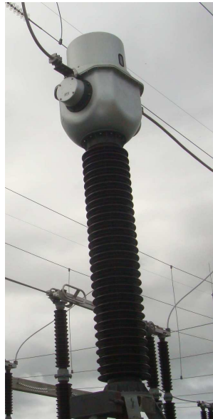
Figura 23: Transformador de Corrente Artech
