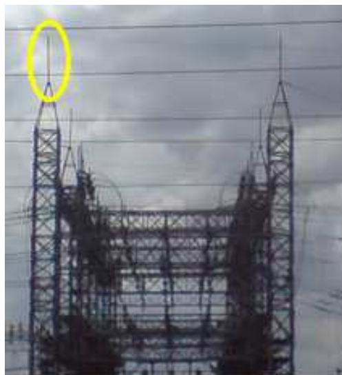
Figura 5 – Destaque para um para-raios tipo haste na SE CGD
