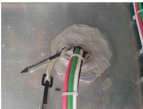
Figura 29 - Vedação dos painéis após a solicitação da Chesf
