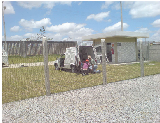
Figura 31 - Ponto de medição da queda de tensão
