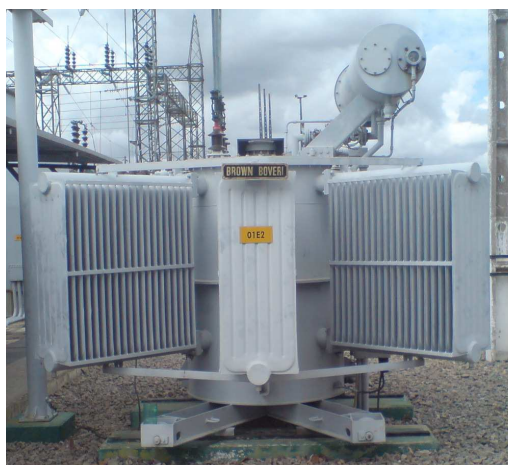
Figura 9 - Reator 01E2 da SE CGD
