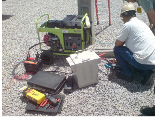
Figura 30 - Gerador de corrente na frequência desejada (70 Hz)
