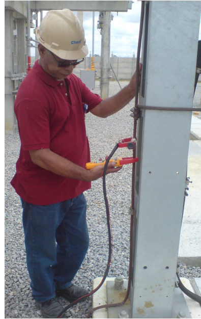
Figura 33 – Medição no ponto (-)
