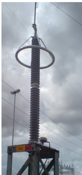
Figura 4 – Para-raios com invólucro polimerico na SE CGD
