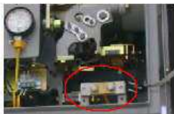
Fig. 8 – Pórtilho de abastecimento de gás SF6
