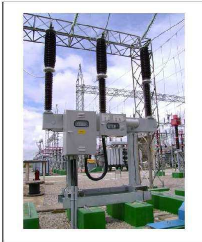
IOE.1145.01 DISJUNTOR CAMARGO CORRÊA 120-SFM-40E – 145kV
