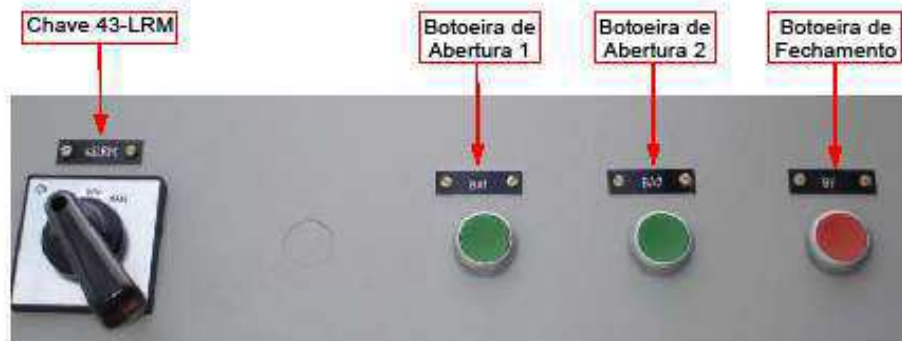
Fig. 14 – Botoeiras de Abertura e Fechamento e chave 43-LRM
