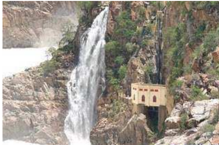
Figura 1 – Usina Hidrelétrica de Angiquinho
