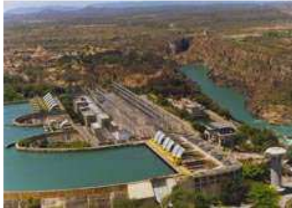
Figura 2 – Complexo de Usinas Hidrelétricas de Paulo Afonso (PAI, PAIIA, PAIIB e PAIII)
