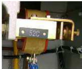
Fig. 23 – Bobina de fechamento do 13D1
