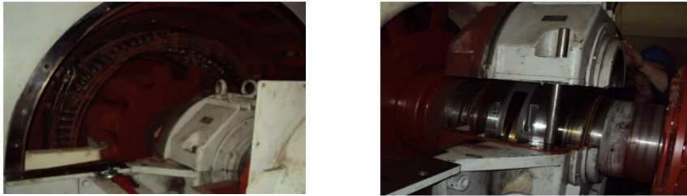
Figura 3.19 – Remoção das tampas dos mancais LA e LOA
