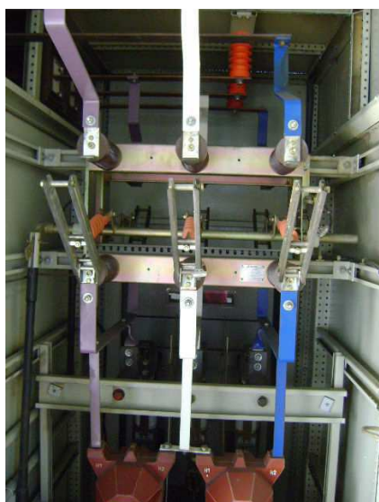
Figura 3.11 – Chave seccionadora
