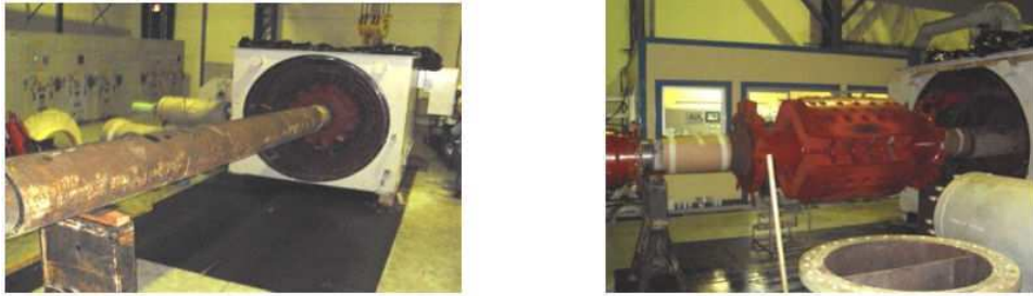
Figura 3.25 – Etapas de remoção do rotor
