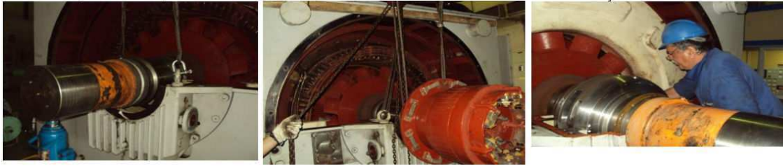
Figura 3.22 – Remoção das tampas inferiores e dos defletores dos ventiladores LA e LOA
