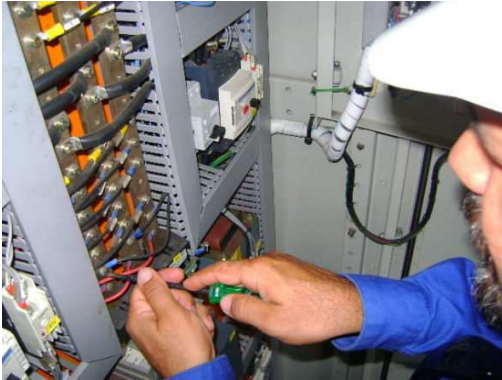
Figura 3.8 – Re-aperto das conexões
