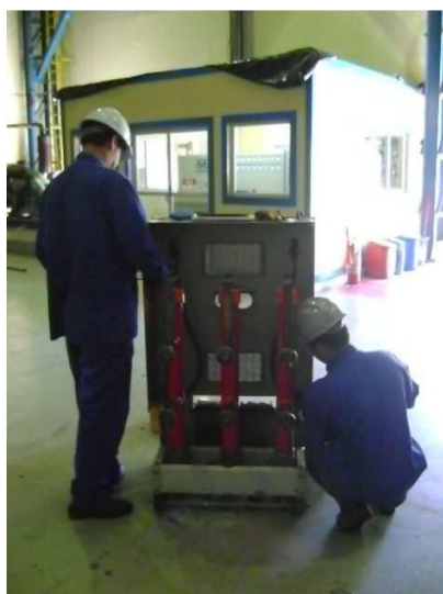
Figura 3.4 – Disjuntor a pequeno volume de óleo
