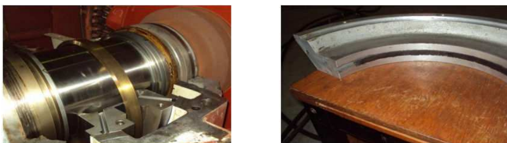
Figura 3.21 – Remoção dos selos flutuantes, anéis pescadores e tampas de vedação
