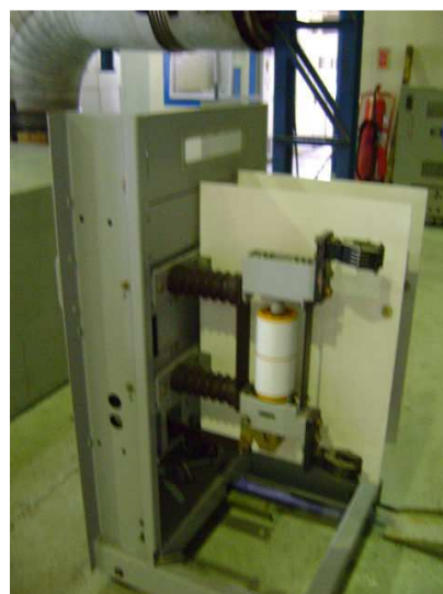
Figura 3.5 – Disjuntor a vácuo
