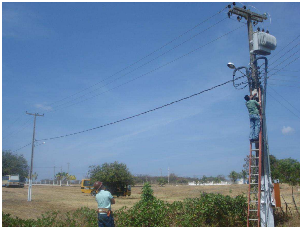
Figura 1 - Transformador de entrada do Campus de Catolé do Rocha.
