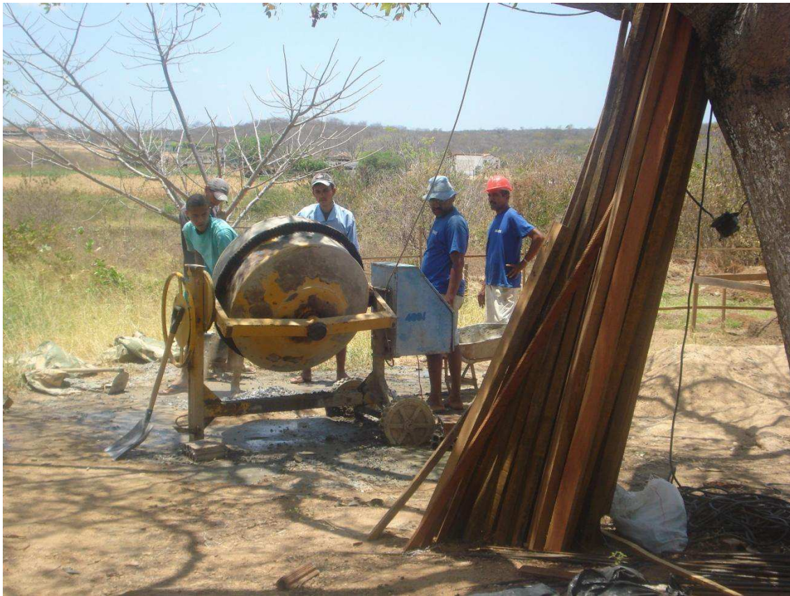
Figura 6 - Betoneira sendo usada no Campus em 29/09/2011.
