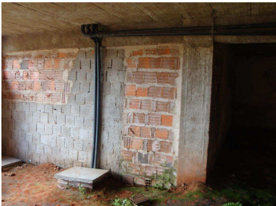
Figura 9 - Subsolo Guarabira – Vista 1.
