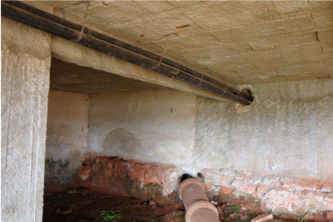
Figura 10 - Subsolo Guarabira – Vista 2.
