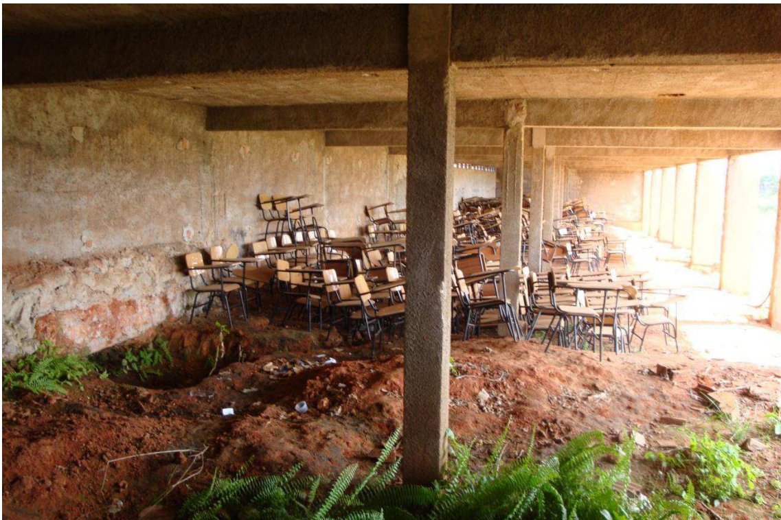
Figura 11 - Subsolo Guarabira – Vista 3.
