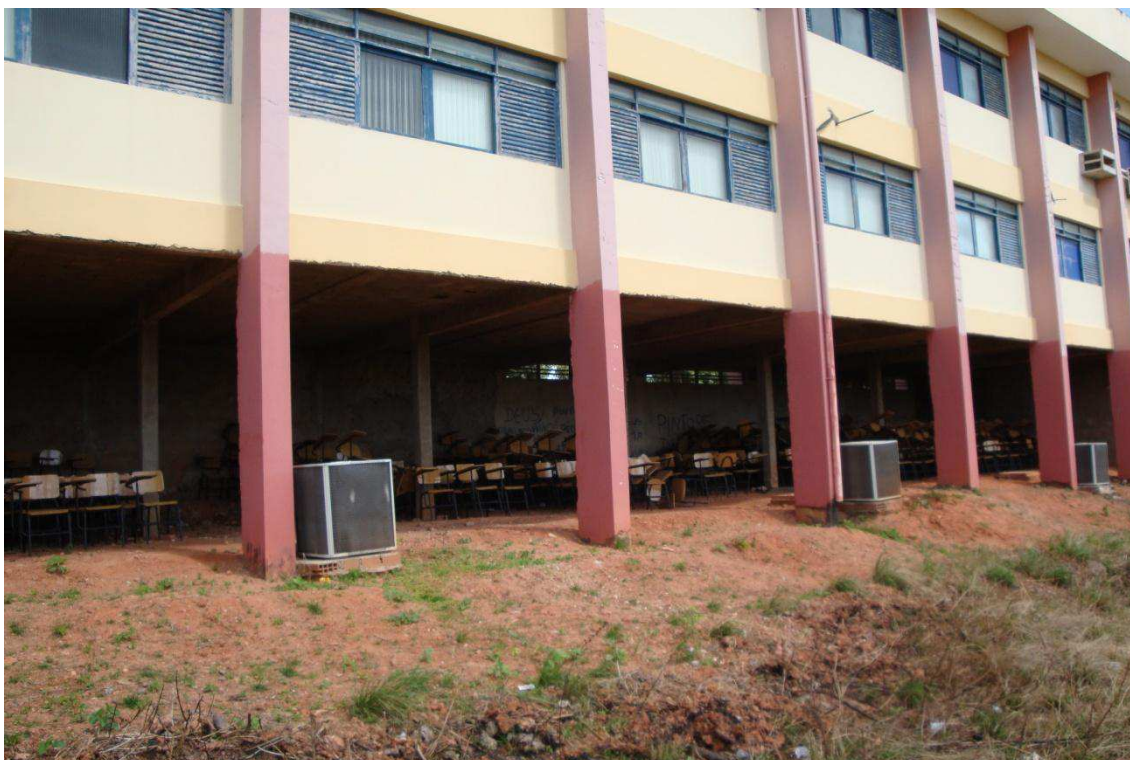
Figura 12 - Subsolo Guarabira – Vista frontal.
